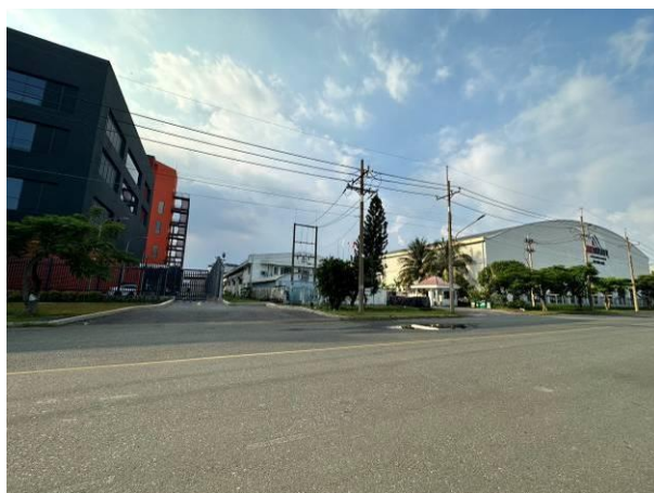
Vị trí giáp với Công ty VNG data Center
