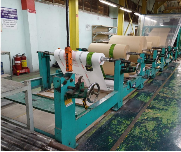
Hệ thống máy tạo ống bao
