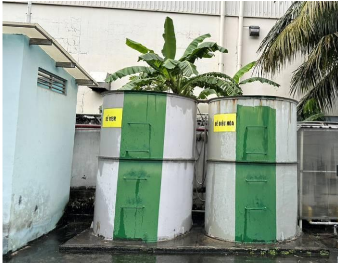
Hình 3.6. Hình ảnh thể hiện cụm bể xử lý sinh học tại nhà máy 1.
