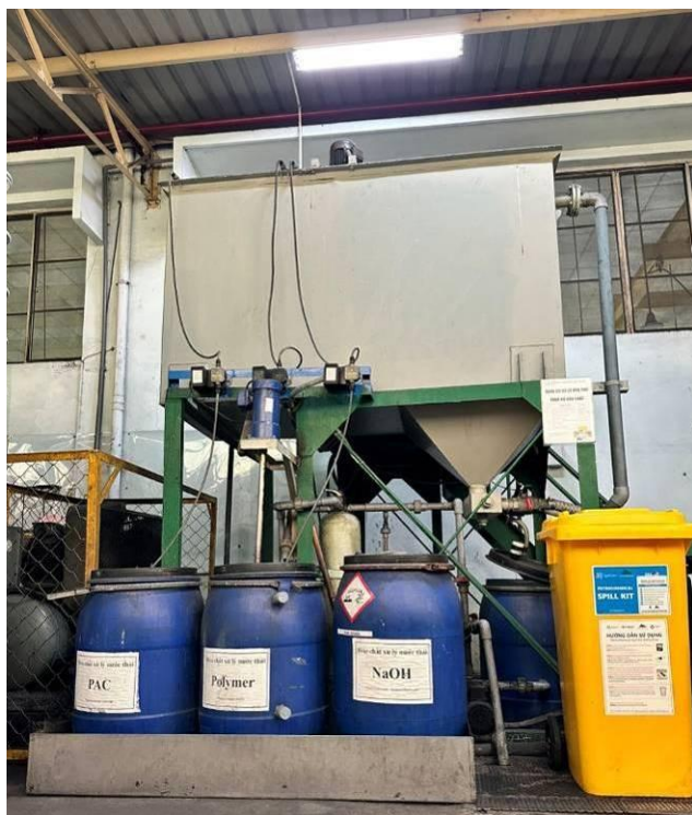
Hình 3.5. Hình ảnh thể hiện cụm bể xử lý hóa lý tại nhà máy 1.
